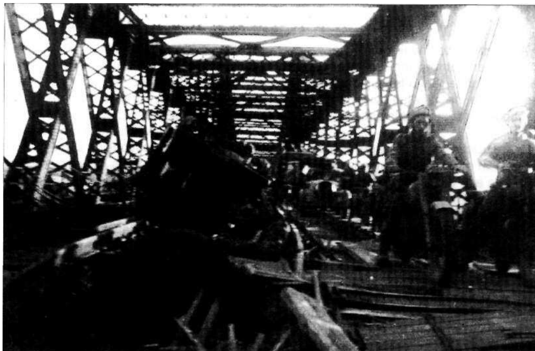
Fig. 7 : Passage de la Seine à Rouen sur le pont de chemin de fer partiellement détruit
