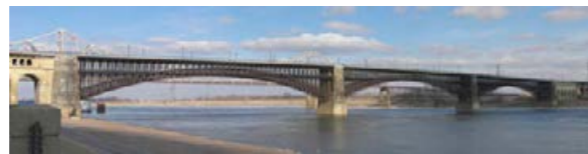
5-Pont de Saint-Louis, aspect actuel (source : Wikipédia)
