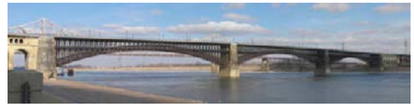
5-Pont de Saint-Louis, aspect actuel (source : Wikipédia)
