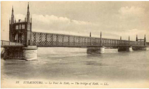
3-Pont de Kehl (source : Bibliothèque nationale et universitaire de Strasbourg)
