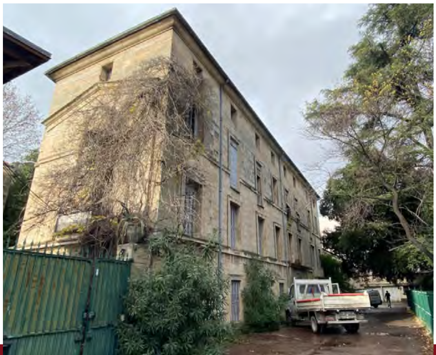
Fig. 22 : Le bâtiment de l'Intendance du Jardin des Plantes, à l'abandon fin 2020.
