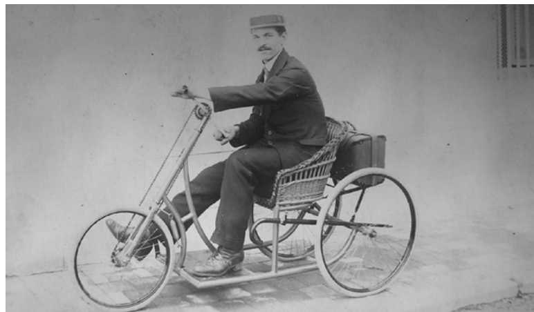
Fig. 19 et 20 : Le Vélocimane de Monnet & Lagoutte (créé en 1913), encore appelé vélo à bras ou « handbike ». Collection Monnet & Goyon à Melle (Deux-Sèvres)
