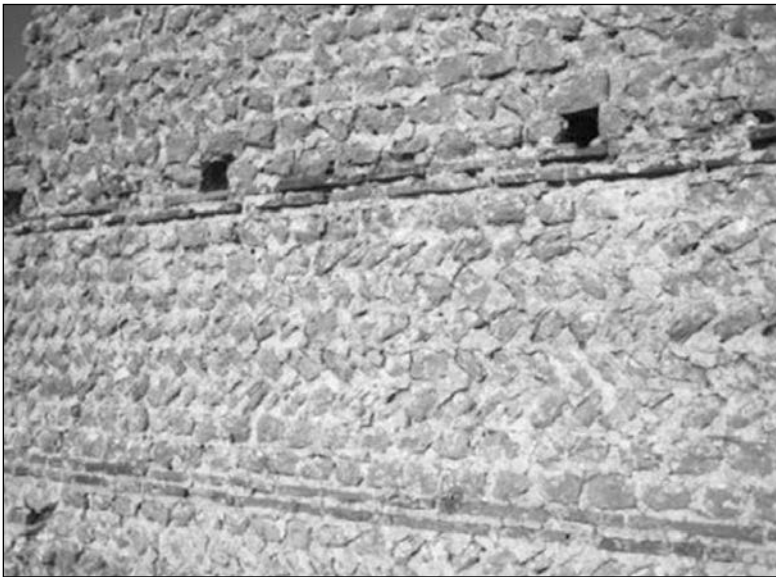
Fig. 5 : mur de Maselles.
