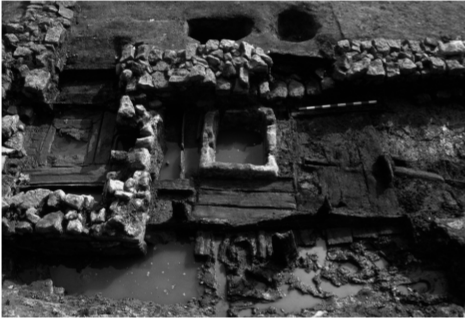
Fig. 5 - Vue sur l'atelier, avec ses bacs en bois et sa cuve en pierre.
