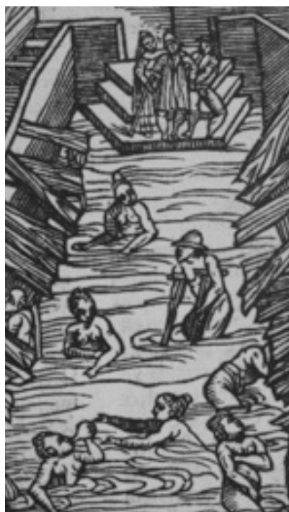
Fig. 5 - Les bains de Plombières (détail).
