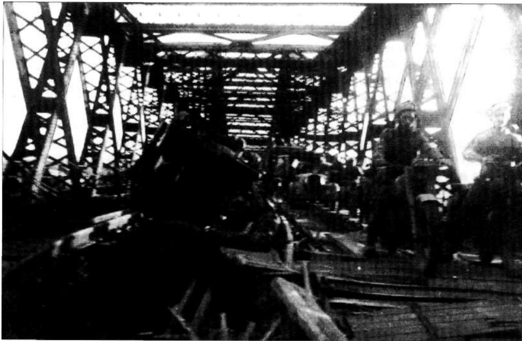
Fig. 7 : Passage de la Seine à Rouen sur le pont de chemin de fer partiellement détruit
