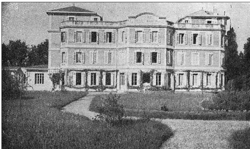
Fig. 1 : L'école Florence Nightingale à ses débuts : façade sud.
